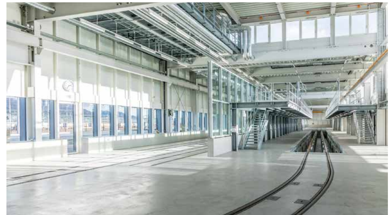
Da die Fahrzeuge zur Ein- und Ausfahrt in die Halle die Batterie nutzen, konnte auf eine schwenkbare Deckenstromschiene verzichtet werden. Dieser Entscheidung bringt zahlreiche Vorteile für einen vereinfachten Betrieb mit sich.
